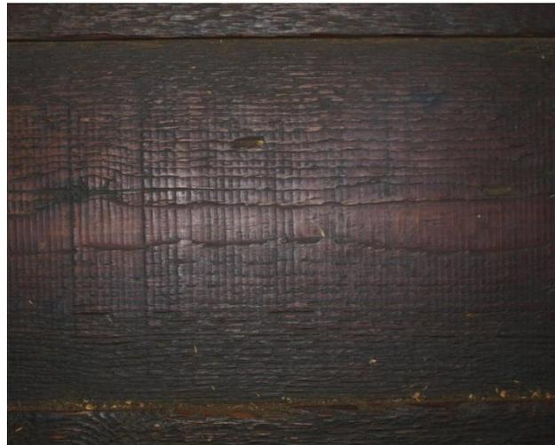
Abb. 31: Sägespuren auf einem Bodenbrett
