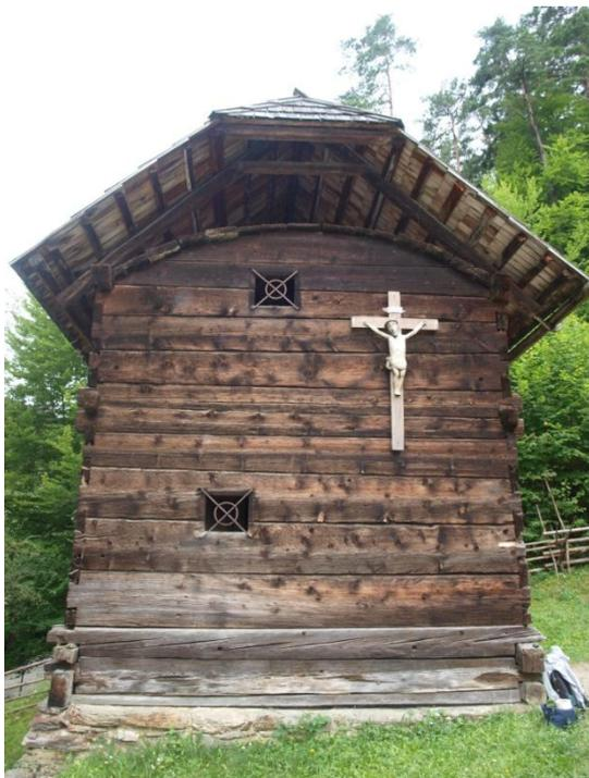
Abb. 28: Wandbalken mit großem Querschnitt
