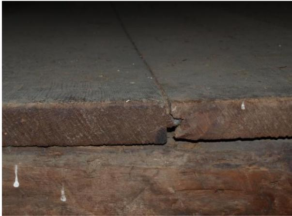
Abb. 26: Bodenbretter mit Eigenfeder
